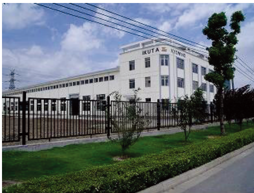
2009 年 7 月に完成した蘇州の新工場
